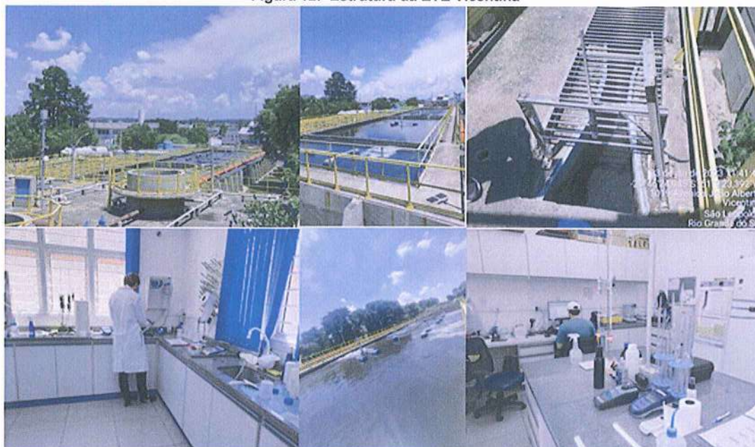
Figura 12: Estrutura da ETE Vicentina
