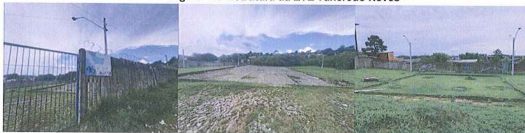
Figura 14: Estrutura da ETE Tancredo Neves
