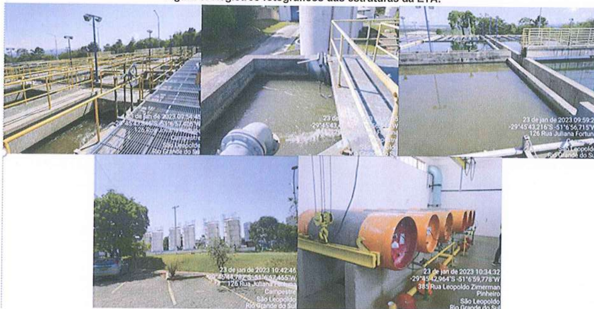
Figura 9: Registros fotográficos das estruturas da ETA.
