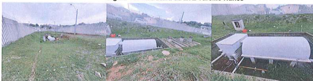
Figura 16: Estrutura da ETE Tarcílio Nunes
