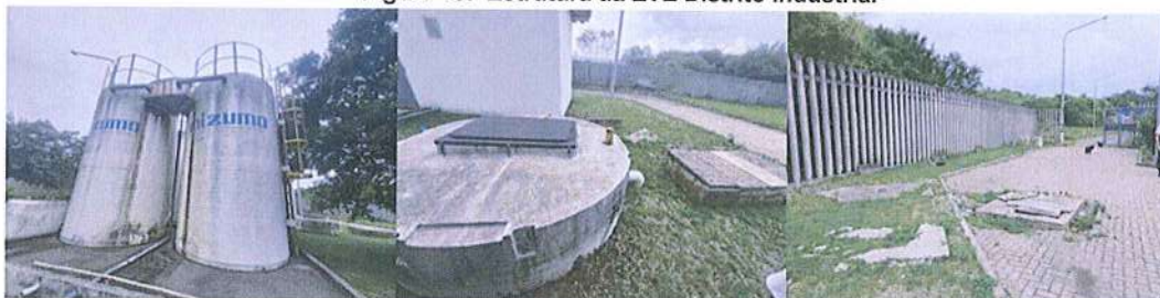
Figura 15: Estrutura da ETE Distrito Industrial
