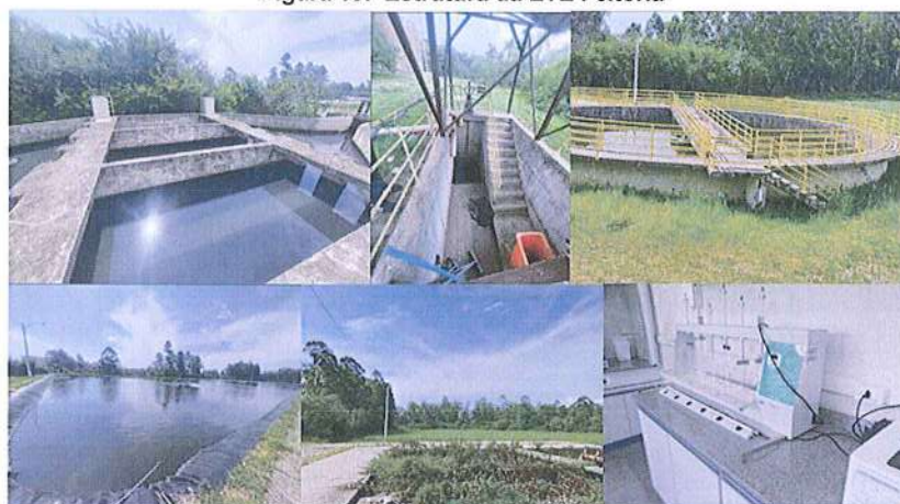
Figura 13: Estrutura da ETE Feitoria
