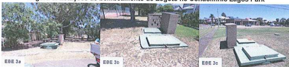
Figura 4: Estações de bombeamento de Esgoto no Condomínio Ilhas Park
