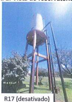
Figura 2: Vista do reservatório R17.
