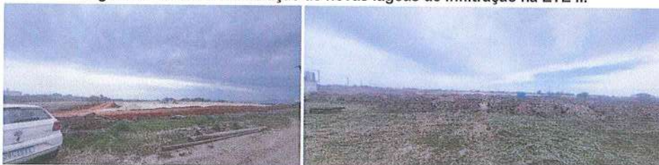
Figura 5: Obras de construção de novas lagoas de infiltração na ETE II.
