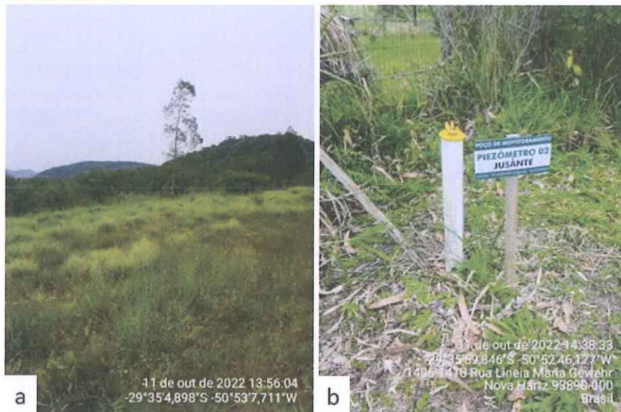
Figura 10 – Registro fotográfico do aterro desativado: a) Vista de uma célula desativada; b) Vista de um dos poços de monitoramento.
