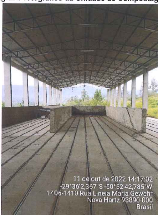
Figura 8 – Registro fotográfico da Unidade de Compostagem desativada
