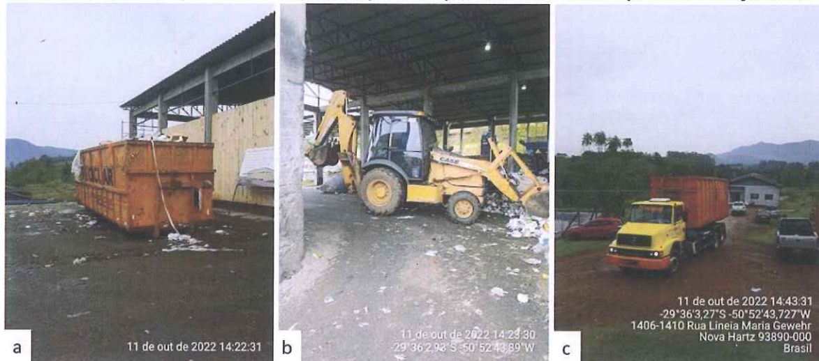
Figura 9 – Unidade de Transbordo de Resíduos: a) Vista do contentor; b) Vista da retroescavadeira que alimenta o contentor; c) Vista do caminhão responsável por enviar os resíduos para a destinação final.
