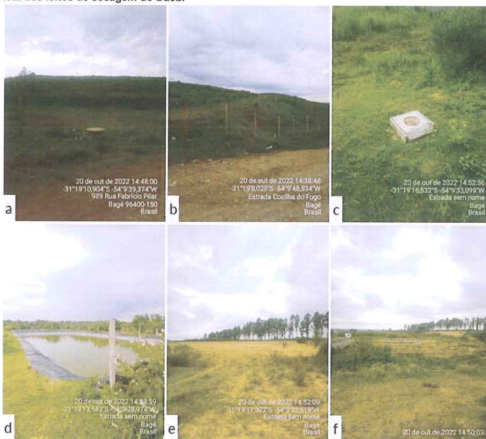
Figura 9: Registro fotográfico do aterro sanitário encerrado; a e b) Vista de células encerradas do aterro; c) Vista de um dos poços de monitoramento; d) Vista da ETE; e) Vista da área prevista para uma possível instalação de nova célula do aterro; f) Vista dos leitos de secagem do Daeb.
