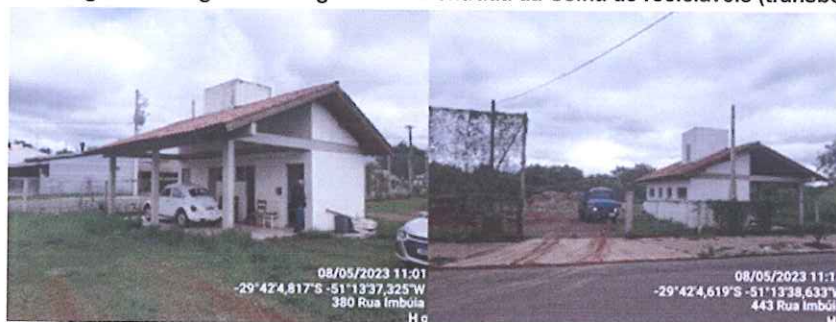
Figura 5 – Registros fotográficos da entrada da Usina de recicláveis (transbordo).
