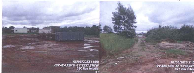
Figura 6 – Registros fotográficos da área interna da Usina de recicláveis (transbordo).
