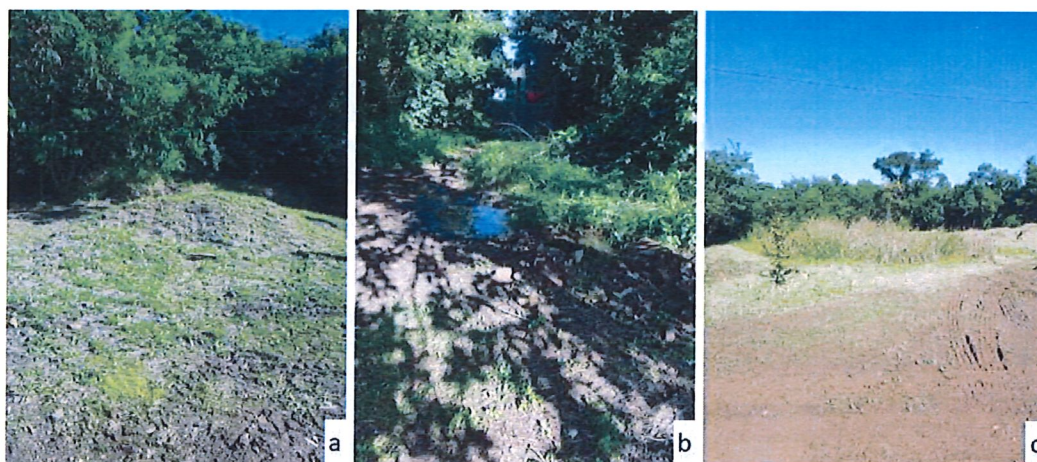
Figura 5 – Registros fotográficos do aterro desativado. a) Vista de uma das células encerradas; b) Vista de um ponto de extravasamento de chorume; c) Vista da lagoa de acúmulo de efluentes com vegetação.
