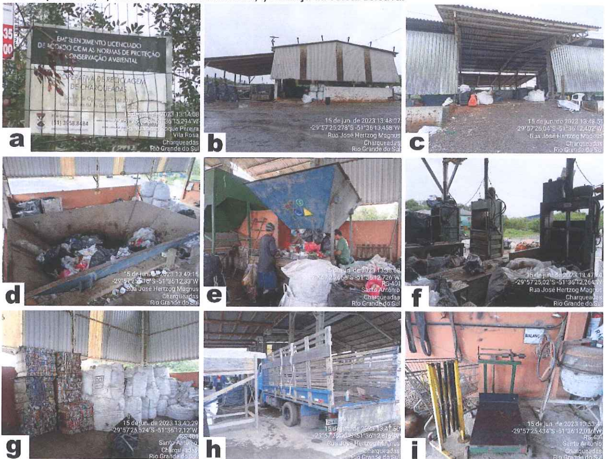
Figura 4: Estação de triagem: a) Placa de licenciamento ambiental, b) Vista geral, c) Entrada de caminhões para alimentação dos funis, d) Vista superior de um funil, e) Vista lateral de um funil e equipe de triagem, f) Prensas, g) Material prensado, h) Caminhão da coleta seletiva, i) Balança da coleta seletiva.
