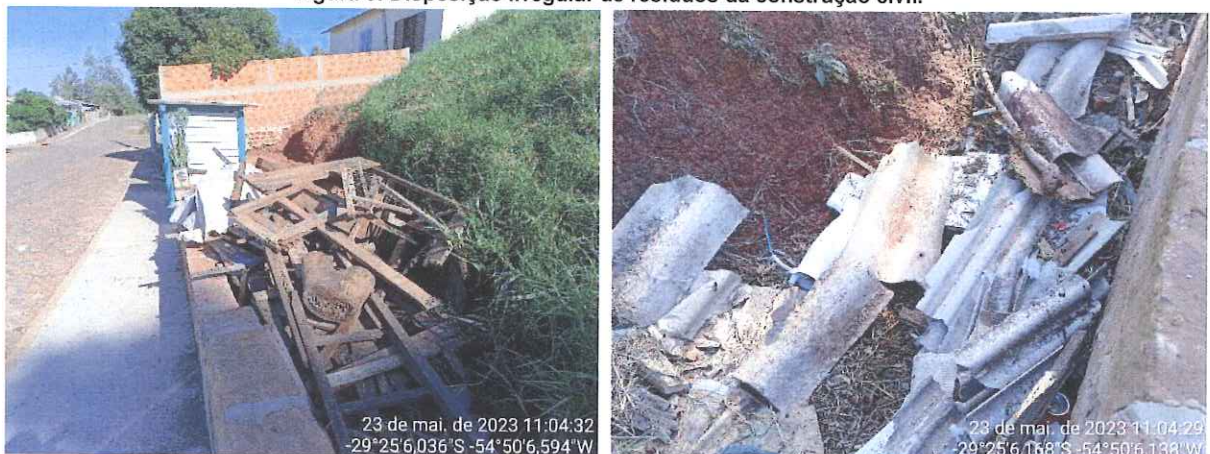
Figura 6: Disposição irregular de resíduos da construção civil.
