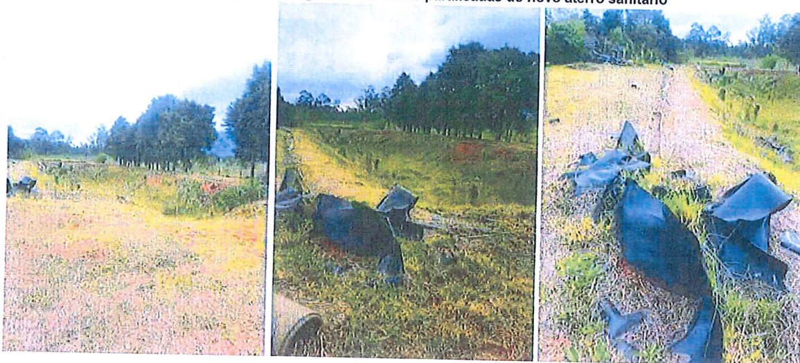
Figura 3: Registro fotográfico das obras paralisadas do novo aterro sanitário
