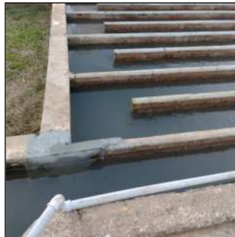
Figura 04: NC 04 - Reparo no floculador executado.
