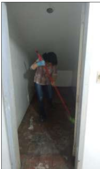
Figura 07: NC 18: Sala de armazenamento de materiais em processo de organização.
