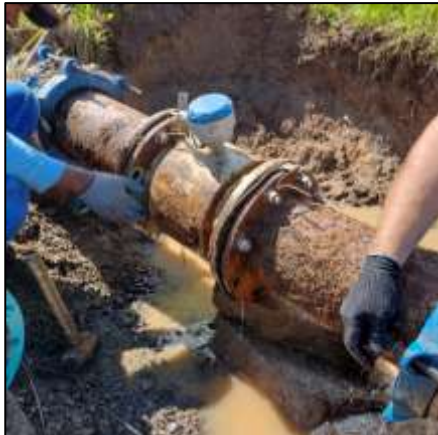
Figura 01: NC 01 - Instalação do macromedidor.
