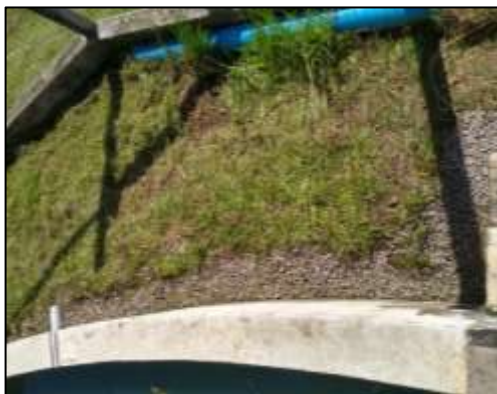
Figura 05: NC 10 – Implementação de vala de drenagem junto ao decantador.
