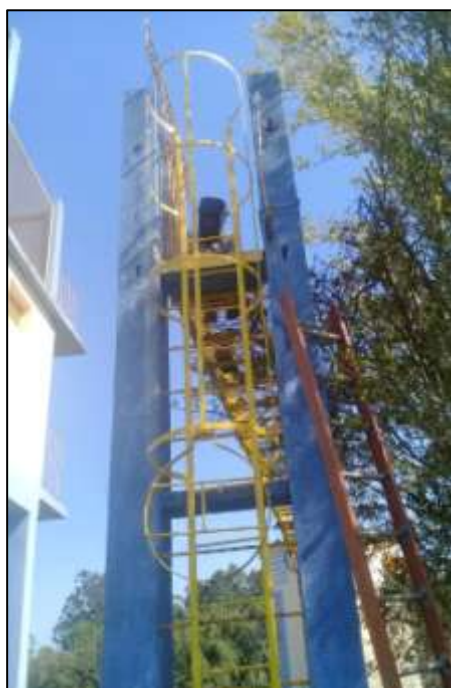
Figura 09: NC 20 - Gaiola de proteção instalada.
