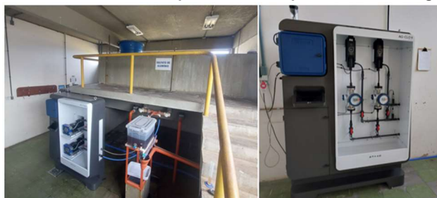
Figura 6: Sistema automatizado para análise de parâmetros e dosagem ótima.
