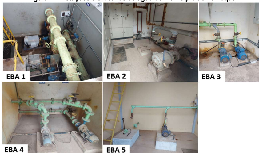
Figura 11: Estações elevatórias de água do município de Camaquã.
