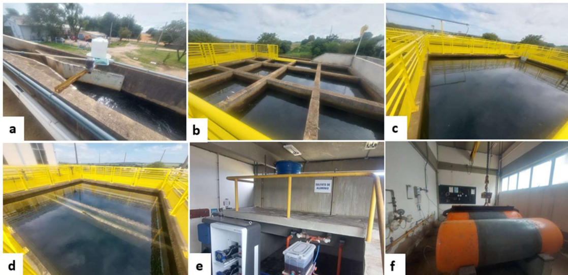
Figura 5: Registros fotográficos das estruturas da ETA: a) Calha Parshall; b) Floculadores; c) Decantador; d) Câmara de mistura do Sulfato de Alumínio; e) Área de armazenamento do cloro gasoso.
