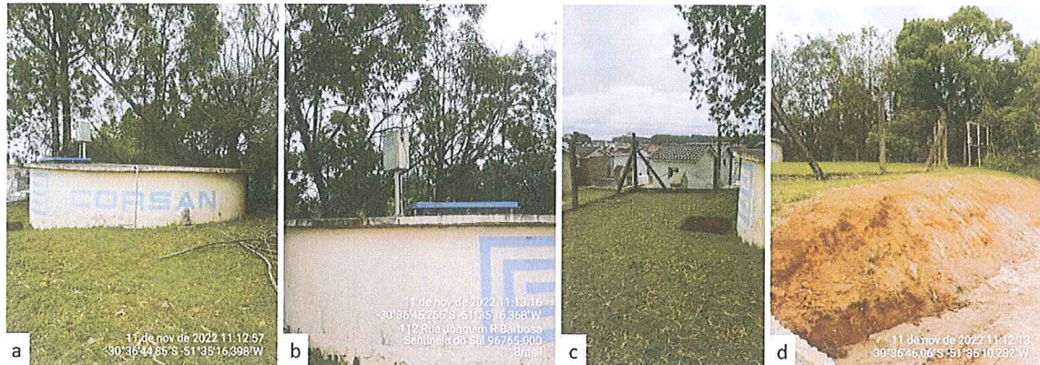
Figura 10: Registro fotográfico do reservatório R-02: a) Vista frontal da unidade; b) Vista do sistema de telemetria da unidade; c) Vista da lateral do reservatório com o cemitério municipal ao fundo; d) Vista da calçada do pátio da unidade pós obras de pavimentação do executivo municipal;
