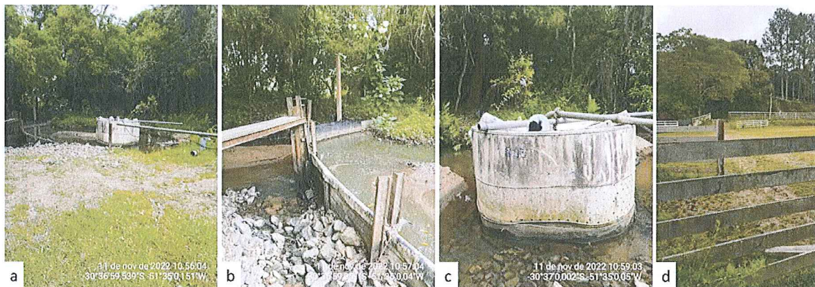
Figura 3: Registro fotográfico da captação superficial: a) Vista geral da captação de água no arroio Santa Cruz; b) Vista do barramento; c) Vista da tomada d'água; d) Vista do Parque Municipal de Eventos
