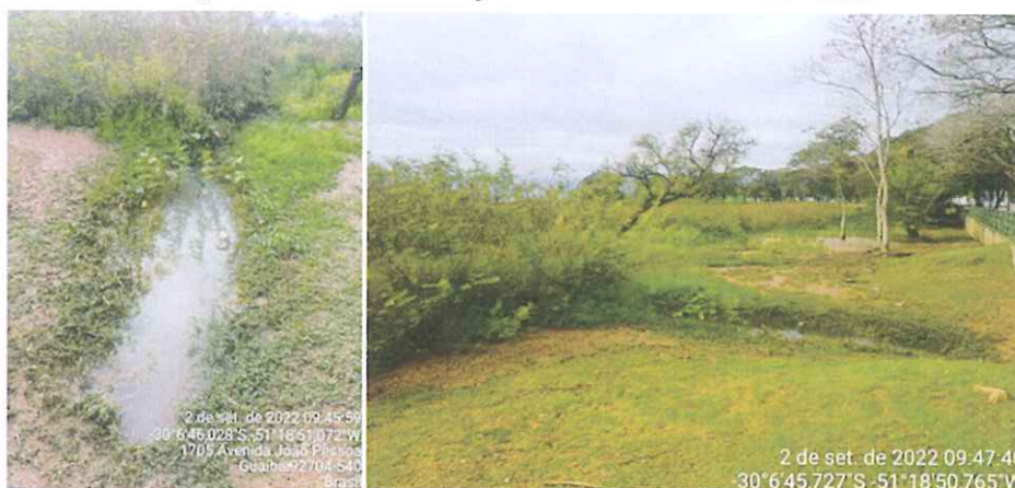
Figura 9 – Vala de lançamento do efluente da ETA.
