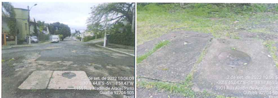
Figura 8 – Estruturas para manutenção da tubulação presente no pavimento.
