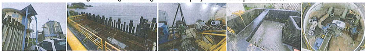
Figura 1: Registro fotográfico da captação no município de Guaíba.
