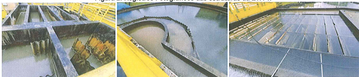
Figura 2: Registros Fotográficos das estruturas da ETA 1.
