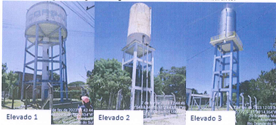
Figura 4 – Registros fotográficos dos reservatórios Arambaré/RS.
