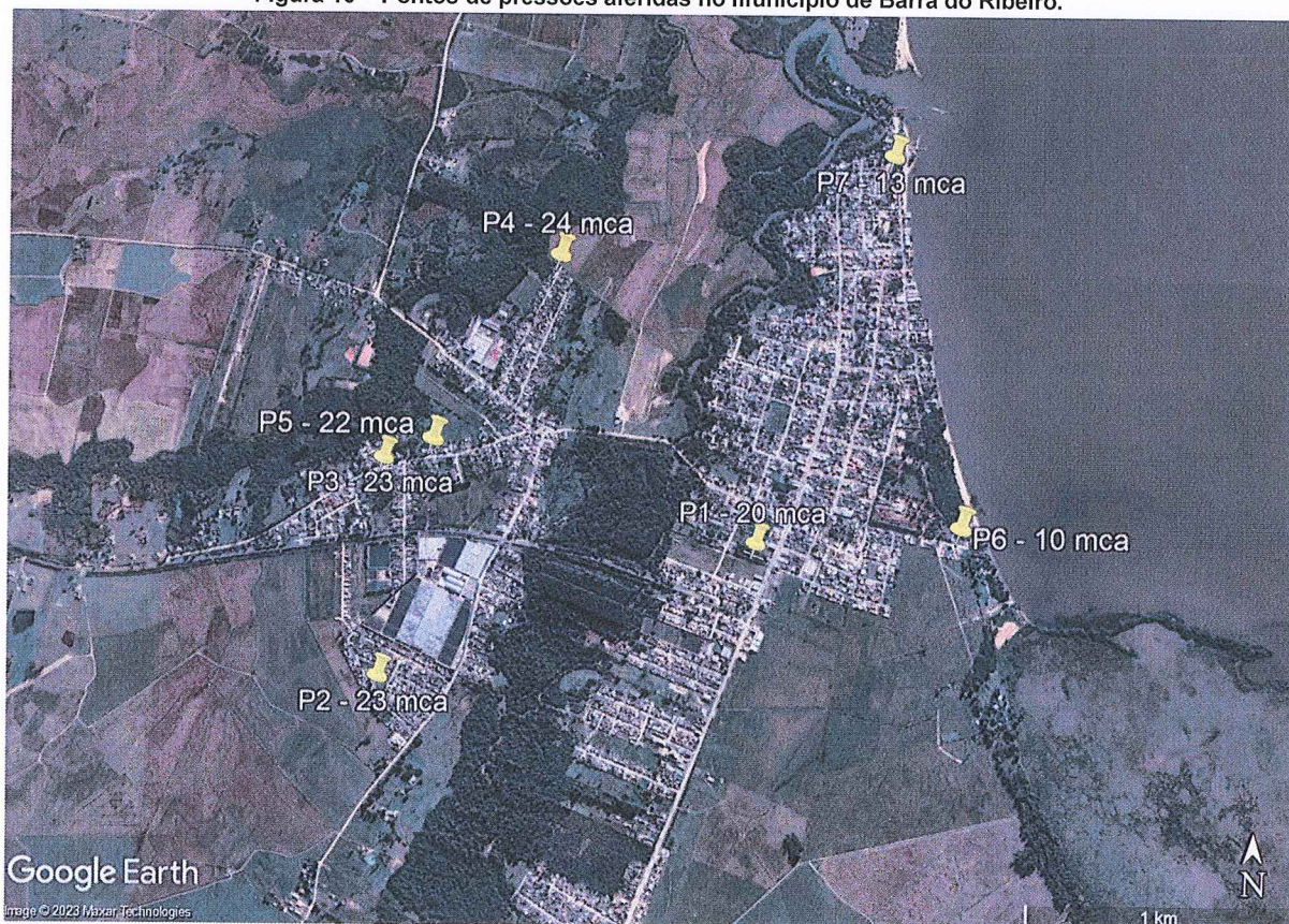
Figura 10 – Pontos de pressões aferidas no município de Barra do Ribeiro.
