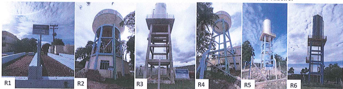
Figura 7: Registros fotográficos dos reservatórios fiscalizados em Barra do Ribeiro.
