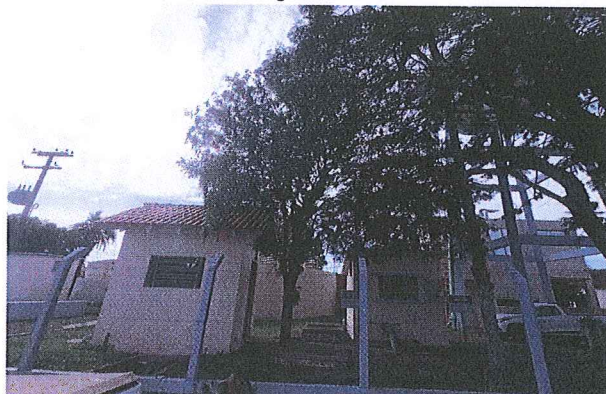
Figura 5: Registros fotográficos das estruturas da ETA.
