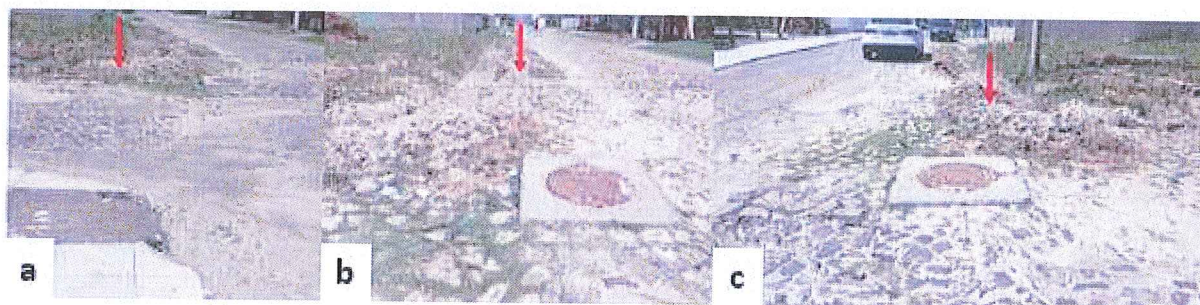
Figura 7 – Registros fotográficos da intersecção das ruas Barros Cassal e Sargento Geraldo Santana: a) Vista do acabamento do projeto está inadequado; b) Vista do meio fio das vias, que não está alinhado c) Vista da camada de solo sobre a pavimentação
