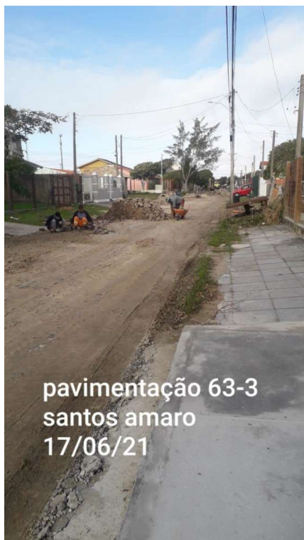
Pavimentação – Santo Amaro
