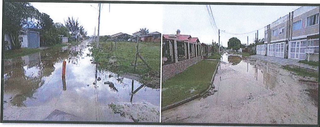
Figura 7: Registros fotográficos das vias alagadas
