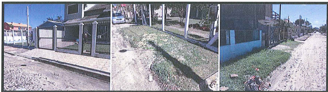
Figura 13: Registros fotográficos de calçadas sem espera de esgoto
