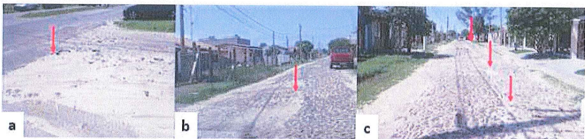
Figura 4 – Registros fotográficos da Rua Santo Amaro: a) Vista da ausência de calçamento no trecho de intersecção; b) Vista dos desníveis no calçamento em trechos próximos às calçadas; c) Vista das diversas irregularidades no pavimento ao longo da via
