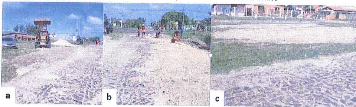
Figura 10 – Registros fotográficos da Av. Deputado Oswaldo Bastos: a) Vista de presença de máquinas; b) Vista de trabalhadores no canteiro de obras; b) Vista do local em que os materiais foram removidos
