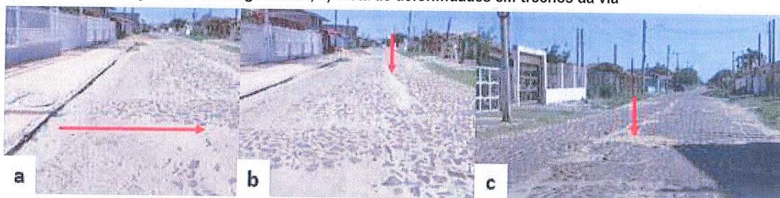
Figura 8 – Registro fotográfico da rua Sargento Geraldo Santana: a) Vista de elevação no pavimento; b) Vista de irregularidades no calçamento ao longo da rua; c) Vista de deformidades em trechos da via
