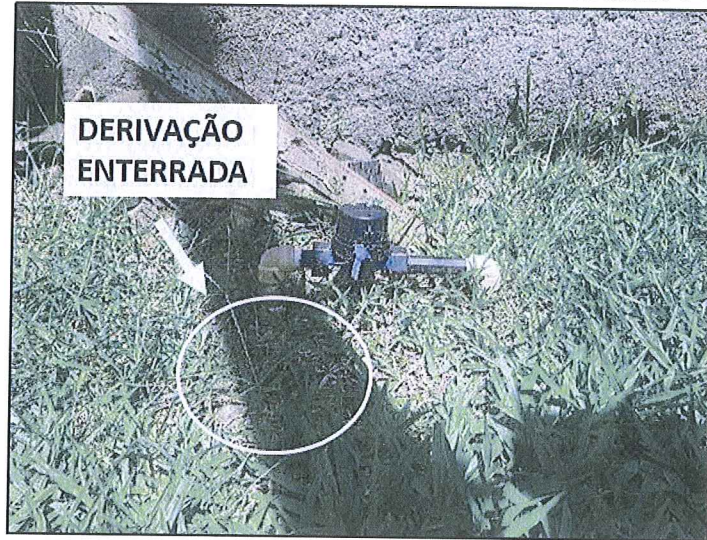
Figura 1- Registro fotográfico do hidrômetro instalado atualmente e de seu entorno
