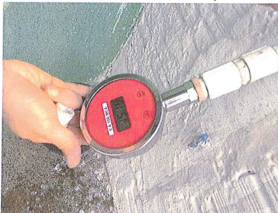
Figura 5: Registro fotográfico da medição de pressão na Rua D, n. 50
