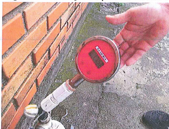
Figura 6: Registro fotográfico da medição de pressão na Rua José Bonifácio, n. 148
