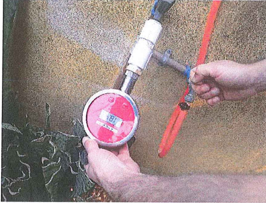
Figura 2: Registro fotográfico da medição de pressão na Rua Érico Veríssimo, n. 29
