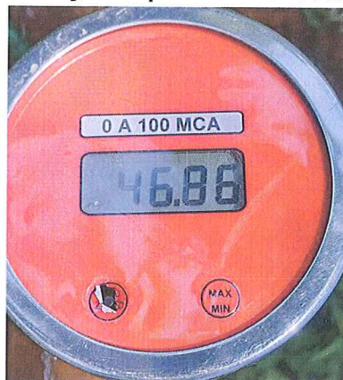
Figura 3: Registro fotográfico da medição de pressão Travessa dos Canudos Esquerda, n. 4.090
