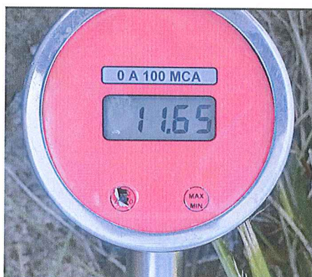
Figura 5: Registro fotográfico da medição de pressão na Travessa dos Canudos Esquerda, n. 5.000
