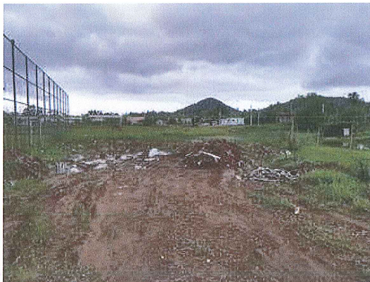
Figura 7 – Registro fotográfico da área de descarte de Resíduos da construção civil
