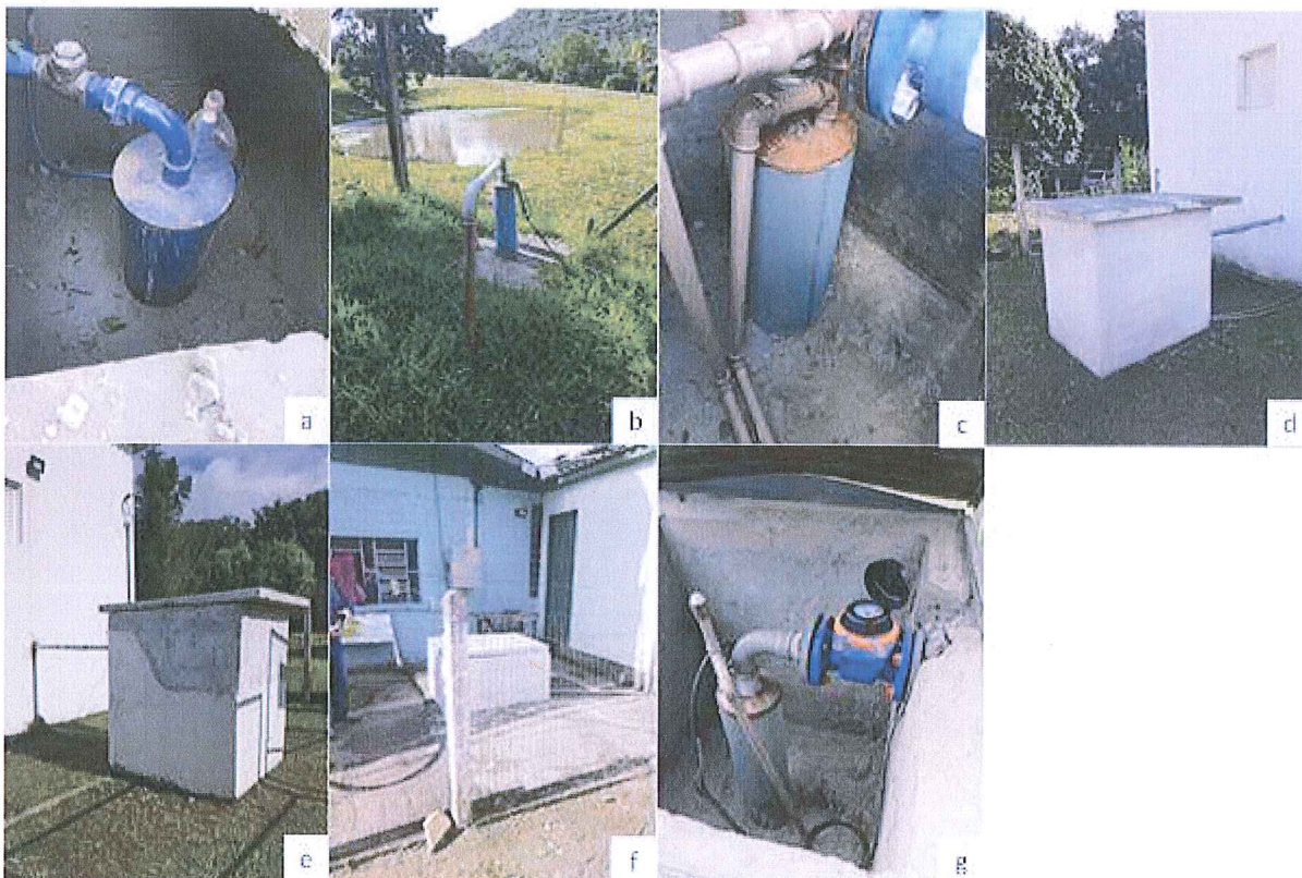
Figura 5: Registro fotográfico dos poços do SAA de Araricá: a) Vista do poço do reservatório b) Vista do poço da Serraria c) Vista do poço da creche; d) Vista do poço P1; e) Vista do poço P4; f) Vista do poço da Secretaria de Obras; g) Vista do poço P7.
