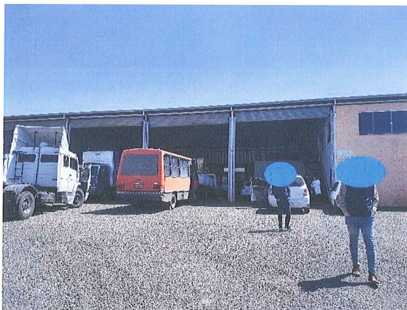
Figura 13 – Registro fotográfico da sede da Trans Ambiental Transportes e Serviços LTDA
