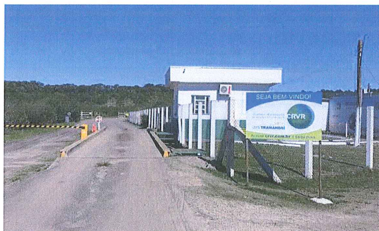
Figura 5 – Vista da balança na entrada da empresa CRVR em Minas do Leão/RS
