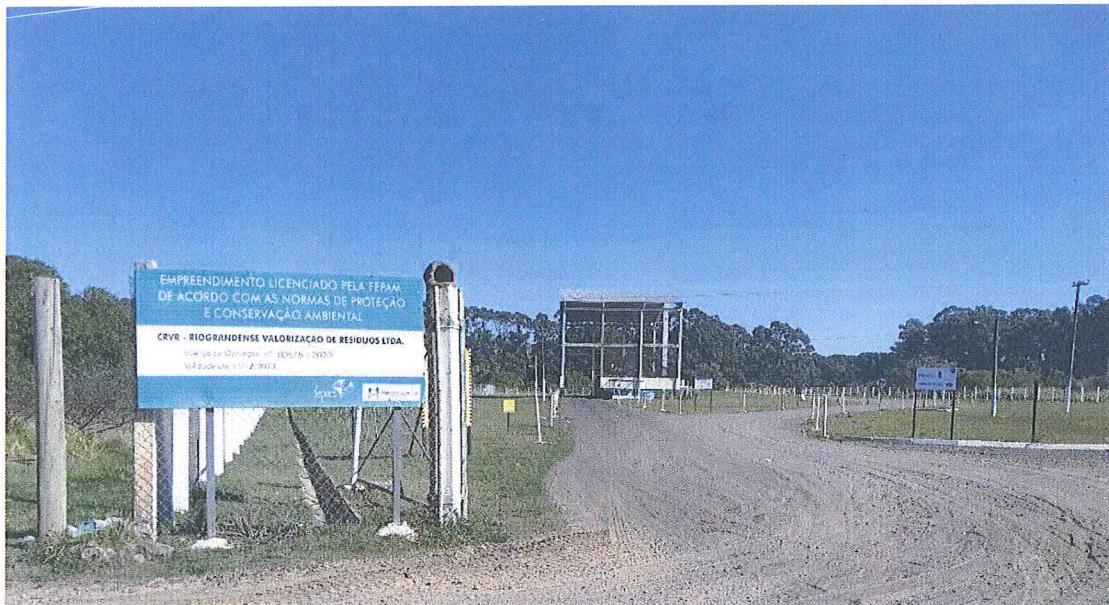
Figura 11 – Registros fotográficos da Área de transbordo da CRVR
