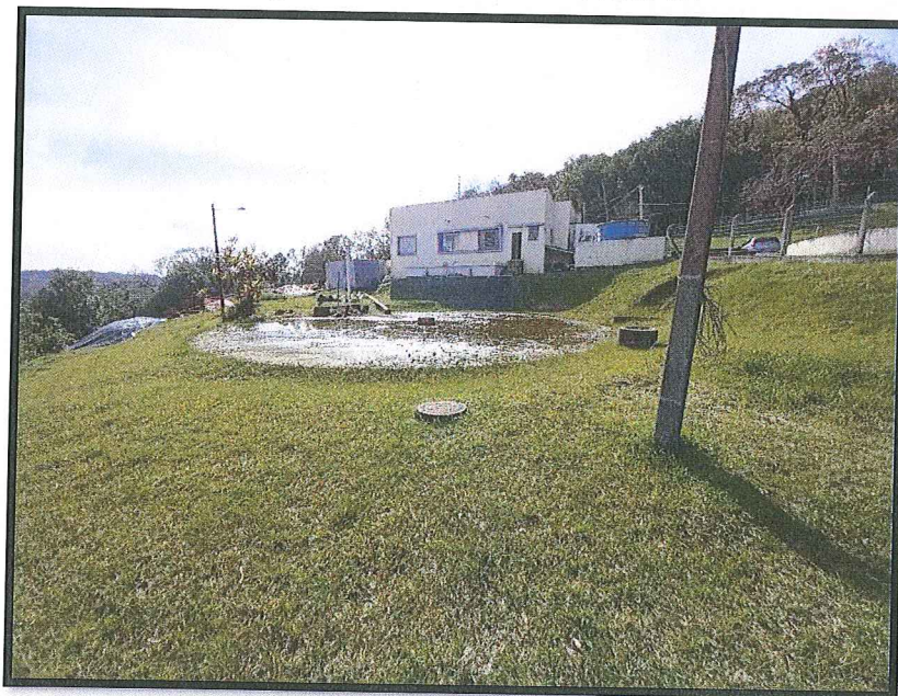
Figura 4: Vista do reservatório R1
