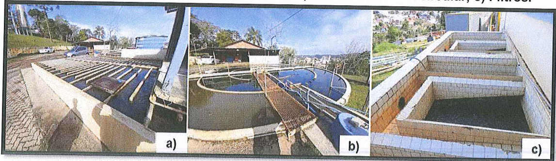
Figura 3: Registros da ETA. a) Floculador; b) Estrutura da ETA circular; c) Filtros.
