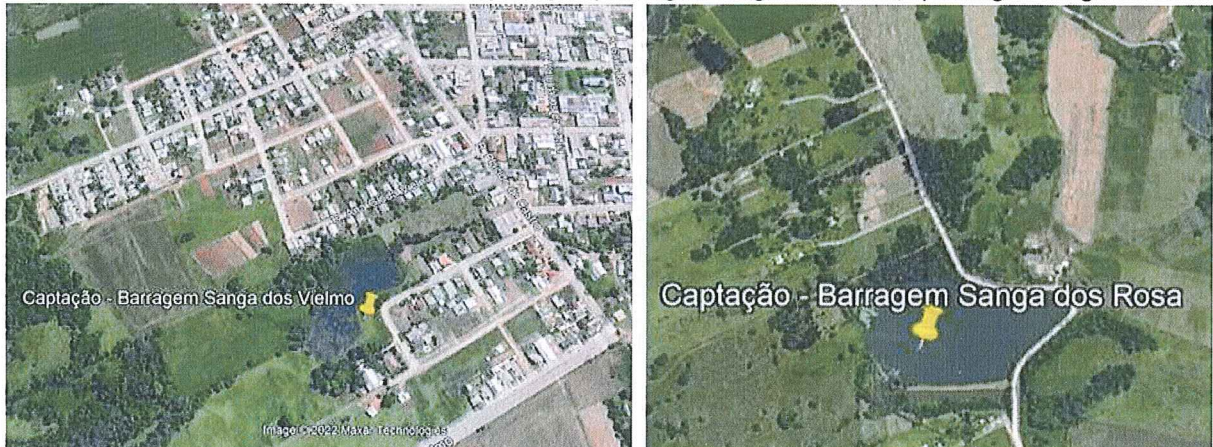
Figura 4: Localização da Captação em Nova Esperança: a) Barragem Sanga dos Vielho; b) Barragem Sanga dos Rosa
