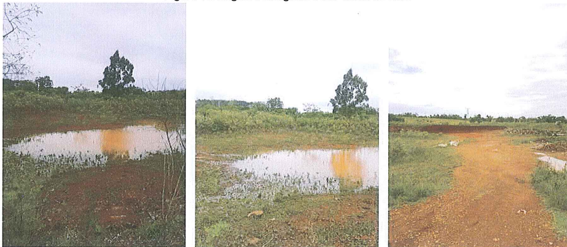
Figura 15: Registro fotográfico das obras de ETE.
