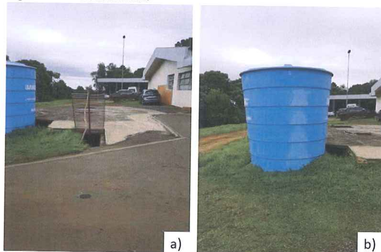
Figura 13: Registro fotográfico do sistema de reservação do hospital municipal: a) Vista geral da cisterna desativada semienterrada; b) Vista geral do novo reservatório
