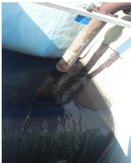
Figura 5. Medição de vazão (macromedidor instalado na câmara de chegada de esgoto).
