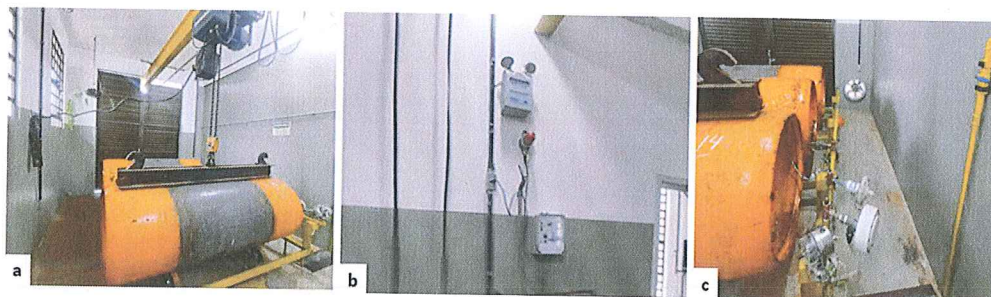
Figura 7: Instalação predial para armazenamento de cloro: a) Cilindros de cloro; b) Sistema de alerta; c) Localização do exaustor.
