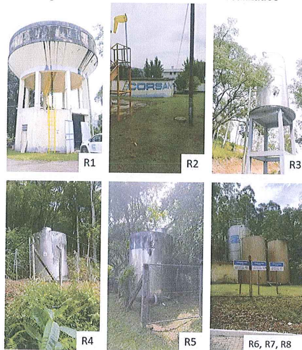
Figura 10: Vista dos reservatórios fiscalizados
