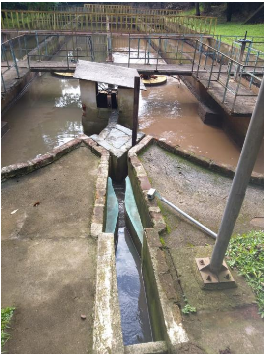
Figura 11: Calha Parshall.
