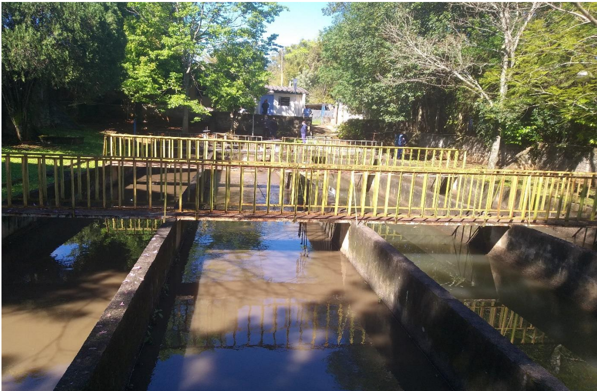
Fig. 14 – Vista Geral da ETE
