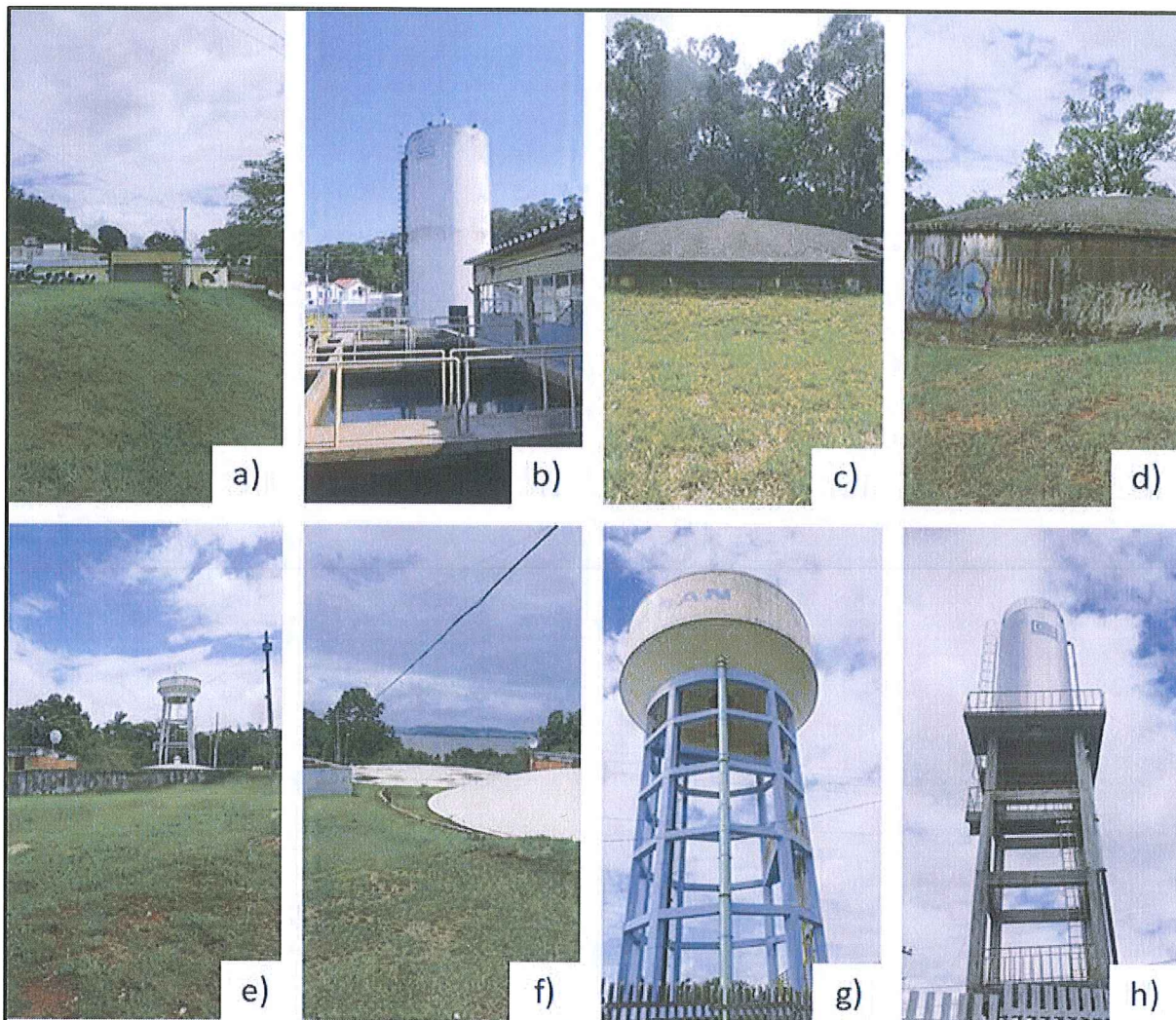
Figura 10: Vista dos Reservatórios vistoriados. a) R-1; b) R-2; c) R-3; d) R-4; e) R-5; f) R-6 e R-7; g) R – Bonfim; h) R – Pedras Brancas
