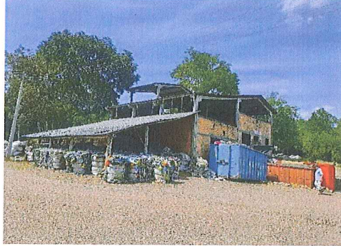
Figura 3: Área externa do centro de triagem
