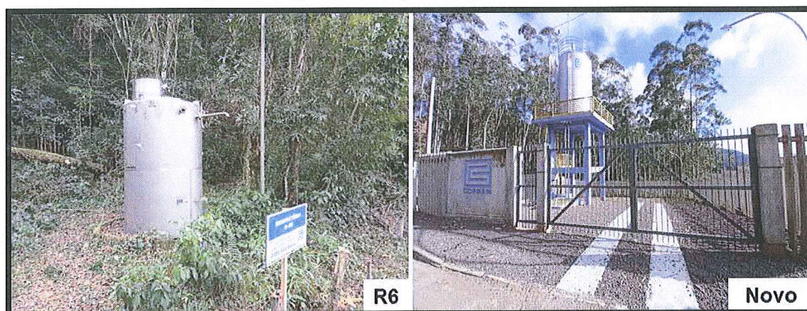
Figura 2: Registros fotográficos dos reservatórios.
