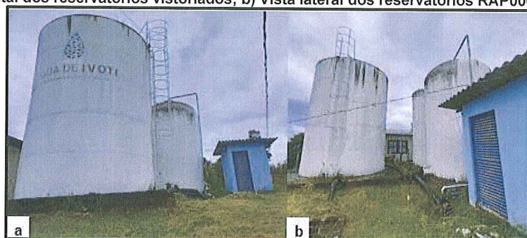
Figura 8: a) Vista frontal dos reservatórios vistoriados; b) Vista lateral dos reservatórios RAP006A, RAP006B, RAP006C
