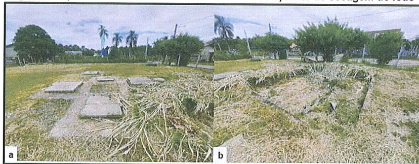
Figura 13: a) Vista da ETE localizado na Rua Colinas b) Leito de secagem do lodo
