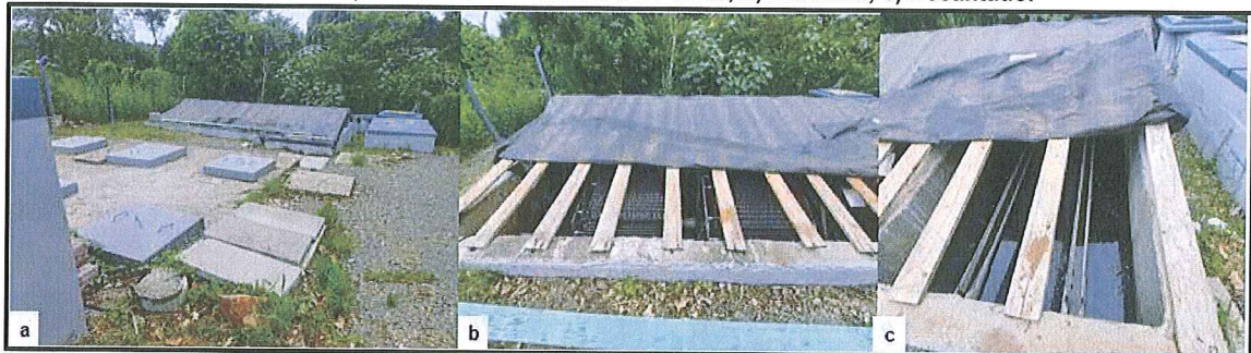
Figura 11: a) Vista da ETE Vivalar Bom Pastor; b) Biodisco; c) Decantador
