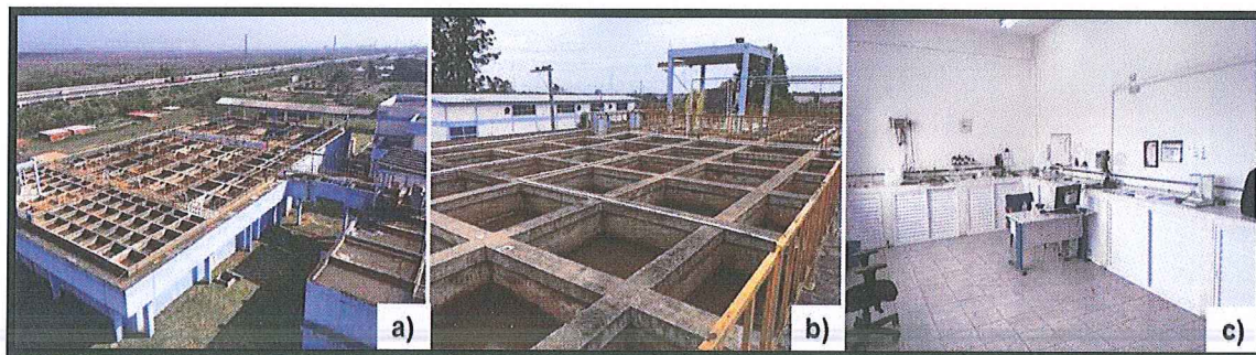
Figura 3: Estação de Tratamento de Água Rio Branco. a) Vista da ETA; b) Vista dos floculadores; c) Vista do Laboratório da ETA
