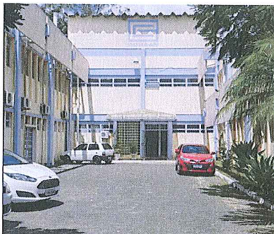
Figura 1: Vista da entrada do Departamento de Ensaio e Apoio Laboratorial (Deal)
