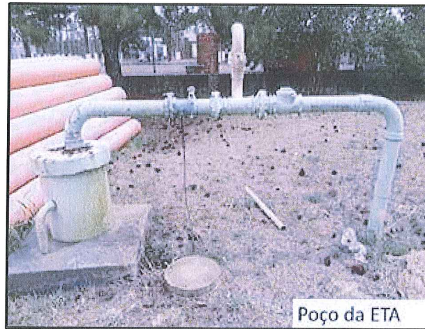
Figura 6: Vista do poço localizado no parque da ETA Atlântida Sul
