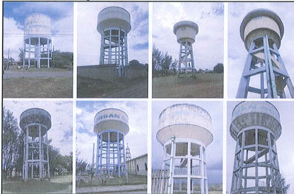
Figura 11: Vista dos Reservatórios vistoriados
