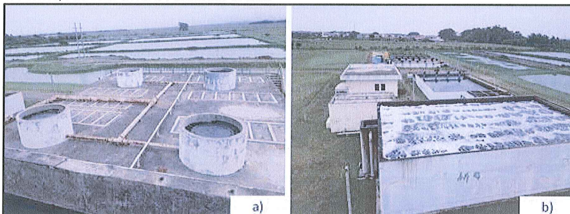
Figura 17: Vistas da ETE II. a) vista do reator UASB e das bacias de infiltração; b) vista dos filtros biológicos aerados submersos, tratamento terciário e tratamento do lodo.
