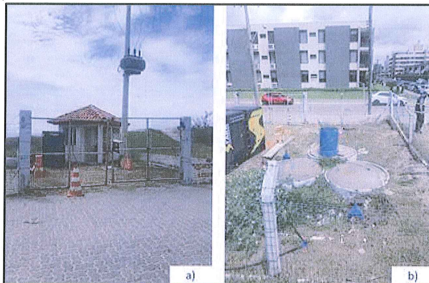
Figura 14: Vista da Estação de Bombeamento de Esgoto em funcionamento. a) Vista frontal da EBE; b) Vista da parte posterior da EBE;
