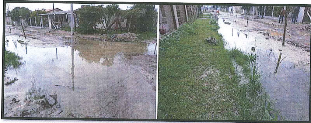
Figura 8: Registros fotográficos das vias com restrições de movimentação de veículos
