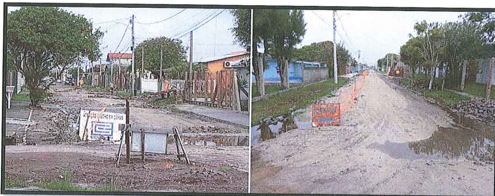
Figura 6: Registros fotográficos das obras em andamento
