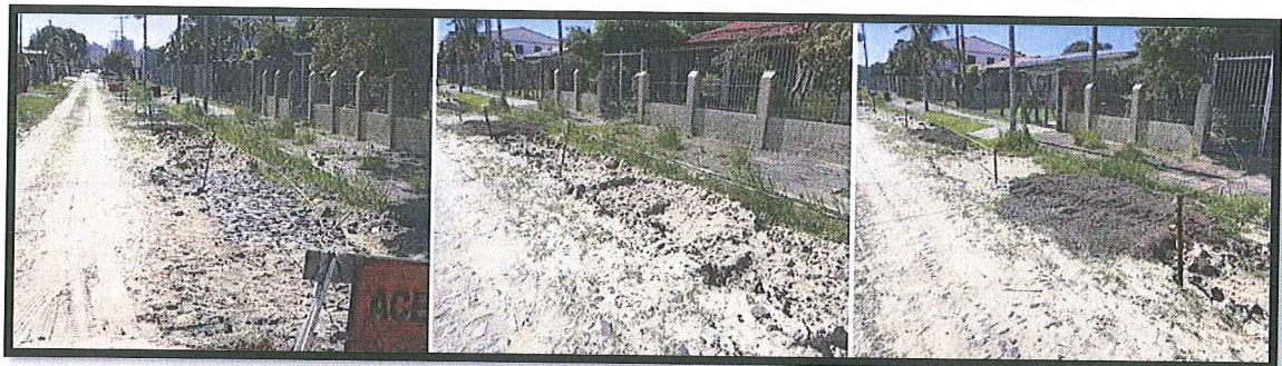
Figura 9: Registros fotográficos da rua Sargento Geraldo Santana
