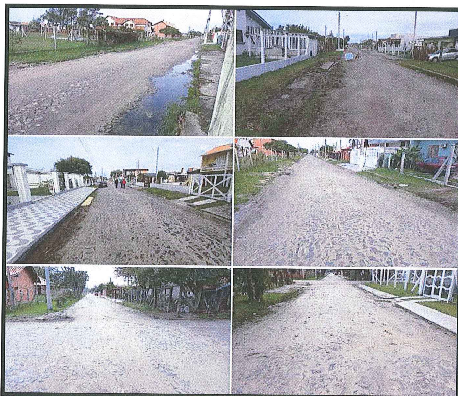
Figura 16 – Registros fotográficos das ruas vistoriadas após conclusão das obras
