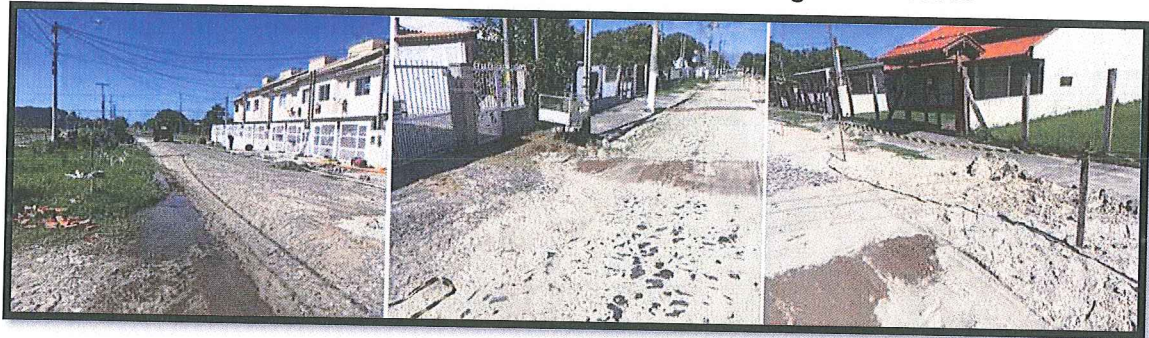
Figura 11: Registros fotográficos da rua Domingos de Moraes
