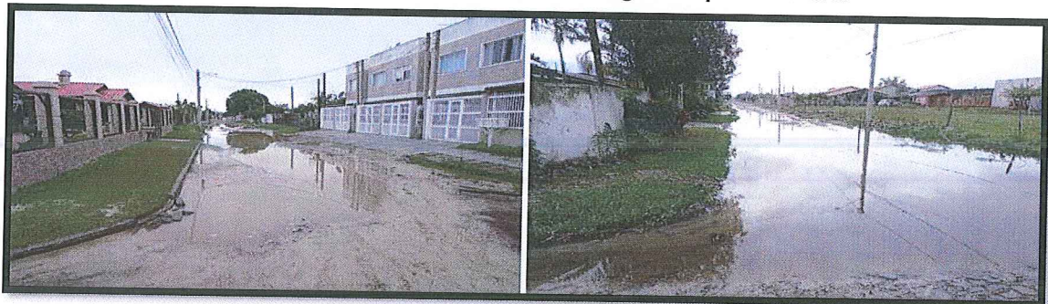
Figura 24 – Vias com acúmulo de água na parte central
