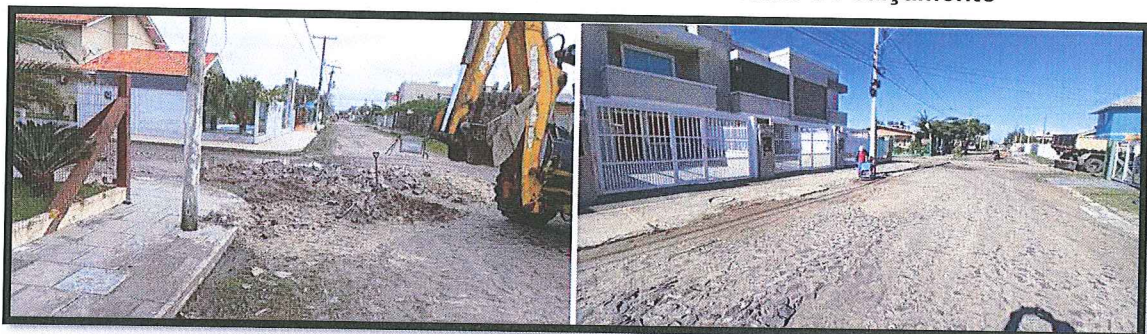
Figura 26 – Registro de atividades de acabamento do calçamento
