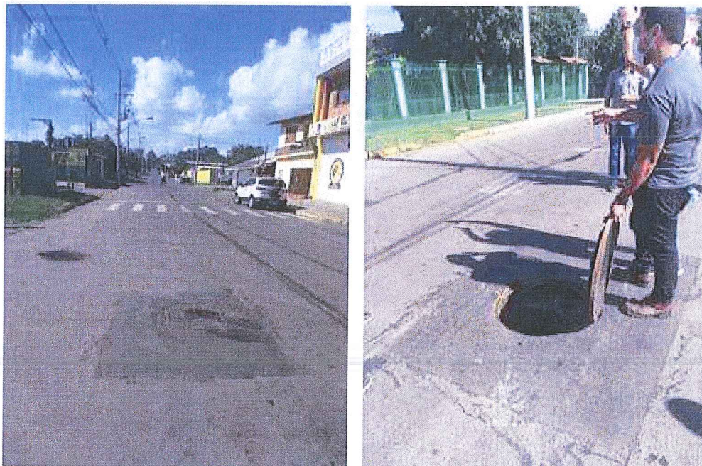
Figura 8: Rede de esgoto na Rua Monteiro Lobato
