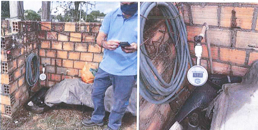
Figura 10: Rua Agnaldo Figueiredo, n. 215 (pressão de 3,7 mca)
