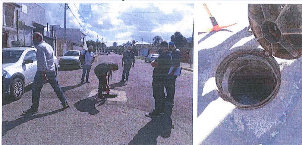
Figura 6: Rede de esgoto na Rua Teodomiro P. da Fonseca
