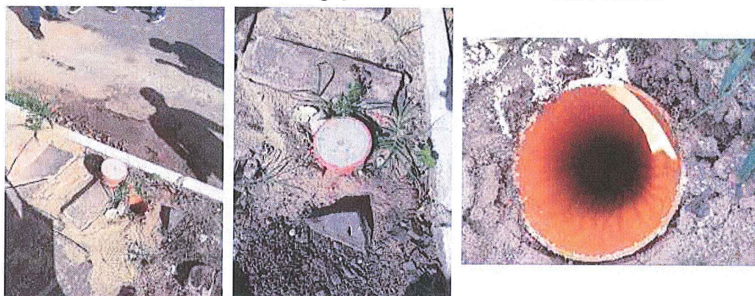
Figura 7: TIL de ligação na Rua Teodomiro P. da Fonseca
