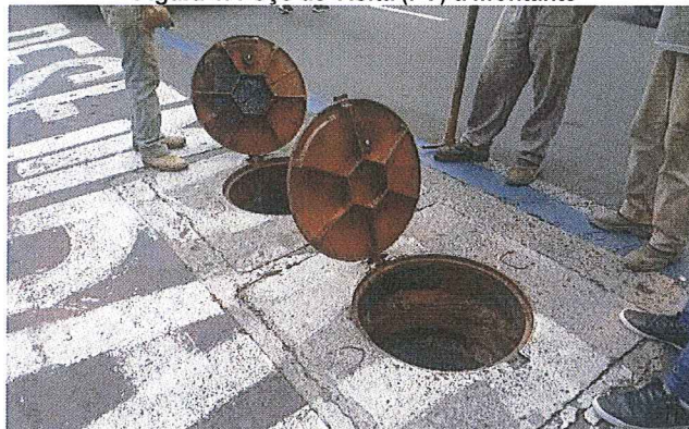
Figura 4: Poço de Visita (PV) a montante
