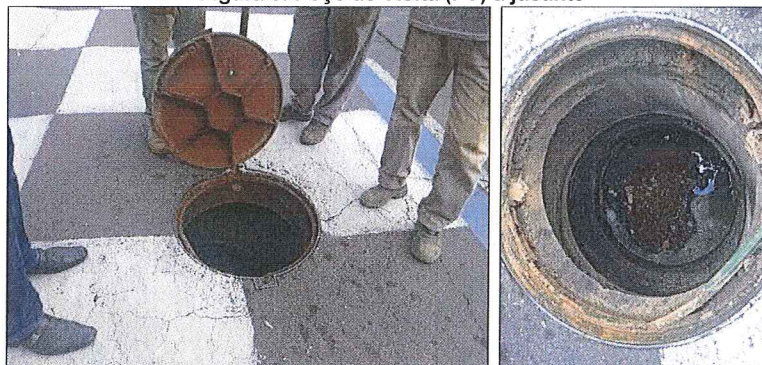
Figura 5: Poço de Visita (PV) a jusante
