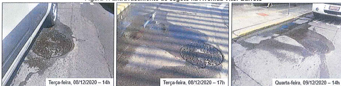
Figura 1: Extravasamento de esgoto na Avenida Vitor Barreto
