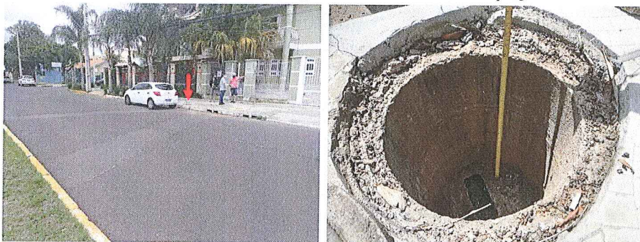
Figura 1: Registro fotográfico da caixa de inspeção
