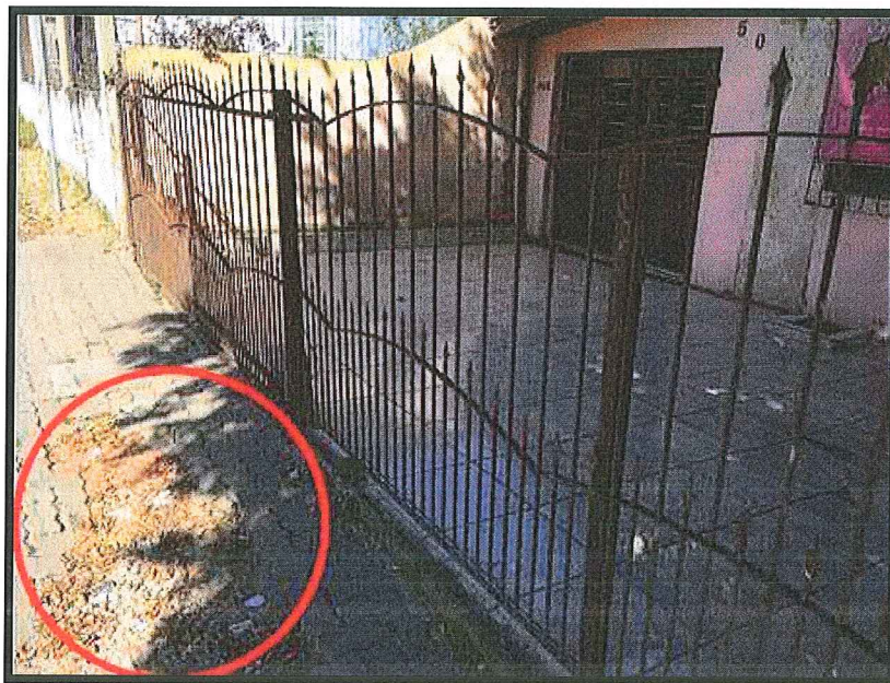
Figura 7: Vista da calçada da residência da Rua Rio Negro, 50.
