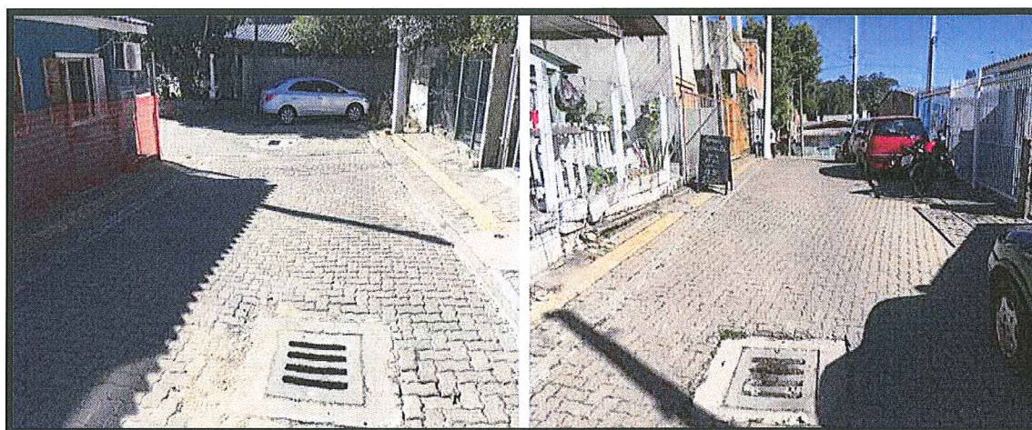
Figura 6: Vista das aberturas da rede pluvial da Rua Dias.
