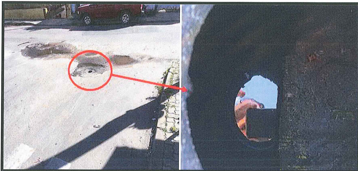
Figura 9: Vista da caixa de passagem à rede pluvial.
