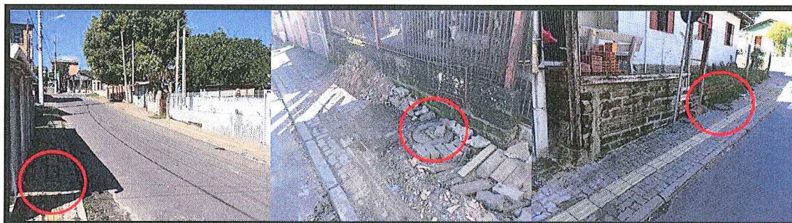
Figura 12: Evidências de caixas de passagem na Rua Rio Negro.
