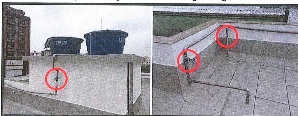
c) A CORSAN substituiu o hidrômetro digital por um hidrômetro analógico durante a ação da fiscalização com o objetivo de facilitar a visualização do fluxo de água através dos ponteiros. Após a substituição, não foi percebido fluxo de água no hidrômetro, o que remete no momento da fiscalização, a instalações prediais de água fria estanques.
