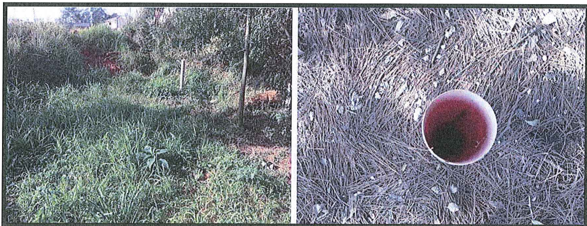
Figura 9: Vistas dos tubos dos tanques da ETE 1.
