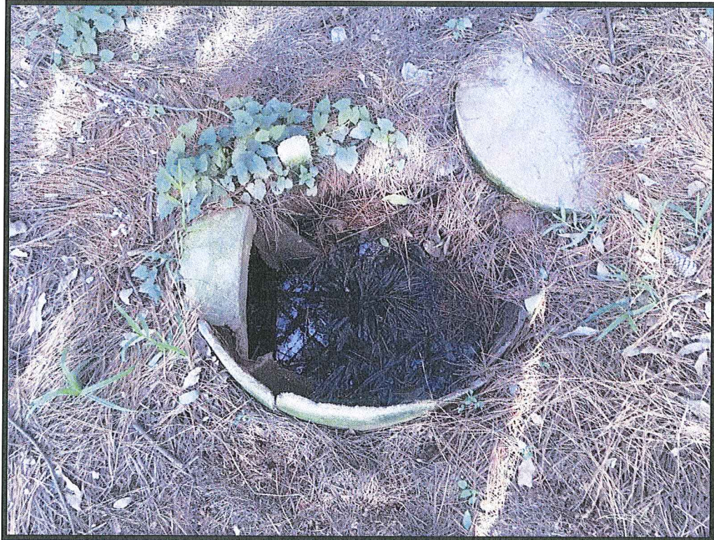
Figura 8: Vistas da caixa de inspeção da ETE 1.
