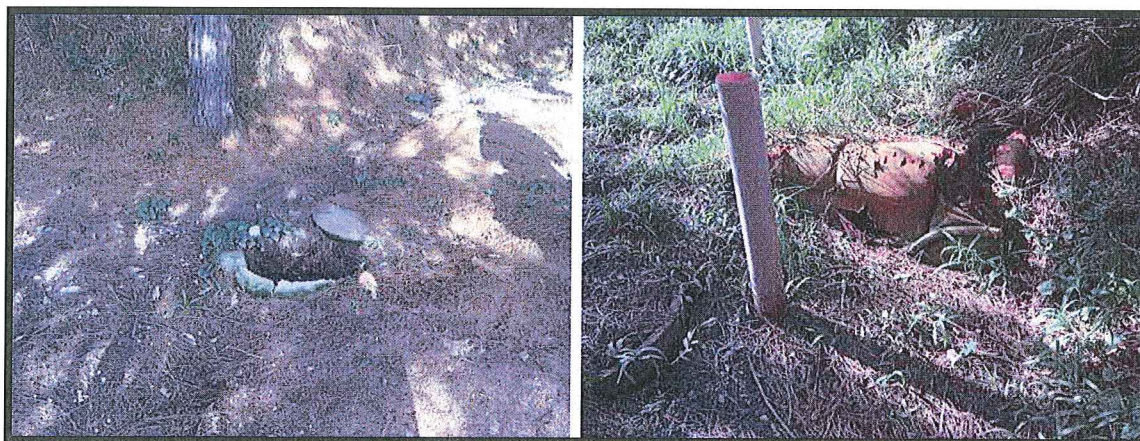
Figura 7: Vistas das caixas de inspeção da ETE 1.
