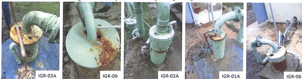
Figura 6: Tampas de vedação e proteção com furos
