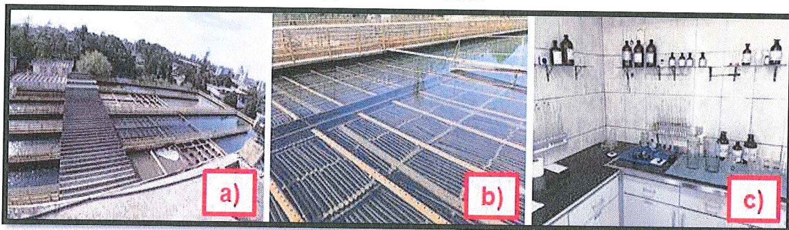
Figura 16: Estação de Tratamento de Água. (a) Vista do Bloco Hidráulico; (b) Vista do Tanque de Sedimentação; (c) Vista do Laboratório
