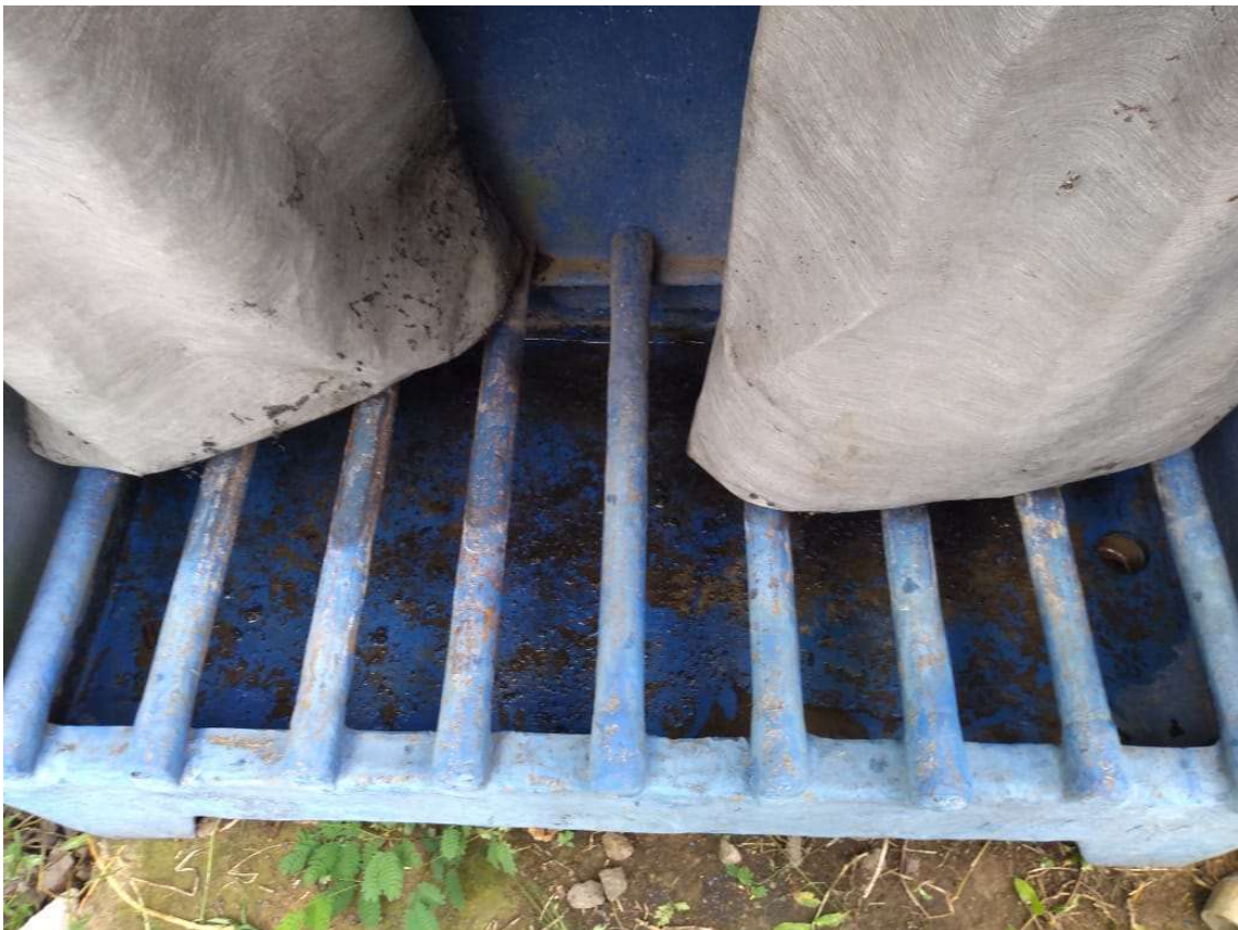
Figura 6. Sistema de drenagem do tipo bags para lodo desobstruído. Posição VI.
