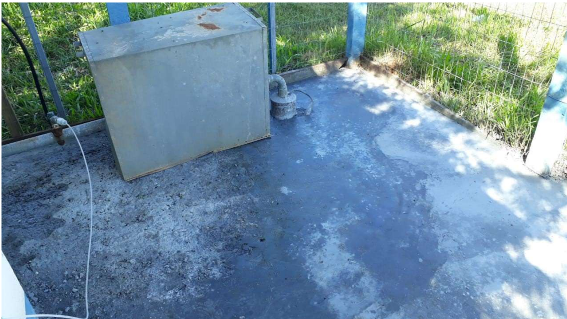
Figura 3. Laje sanitária reconstituída. Posição II.
