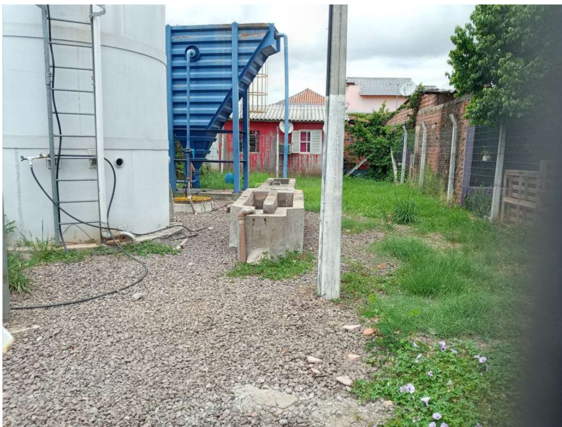
Figura 1. Fotografia do terreno da estação com a roçada efetuada.
