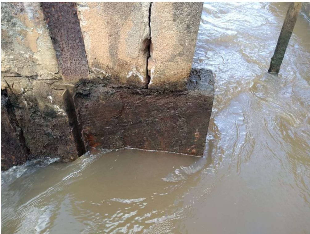
Figura 5. Unidades de tratamento de água do bloco hidráulico após procedimento de limpeza. Posição V.
