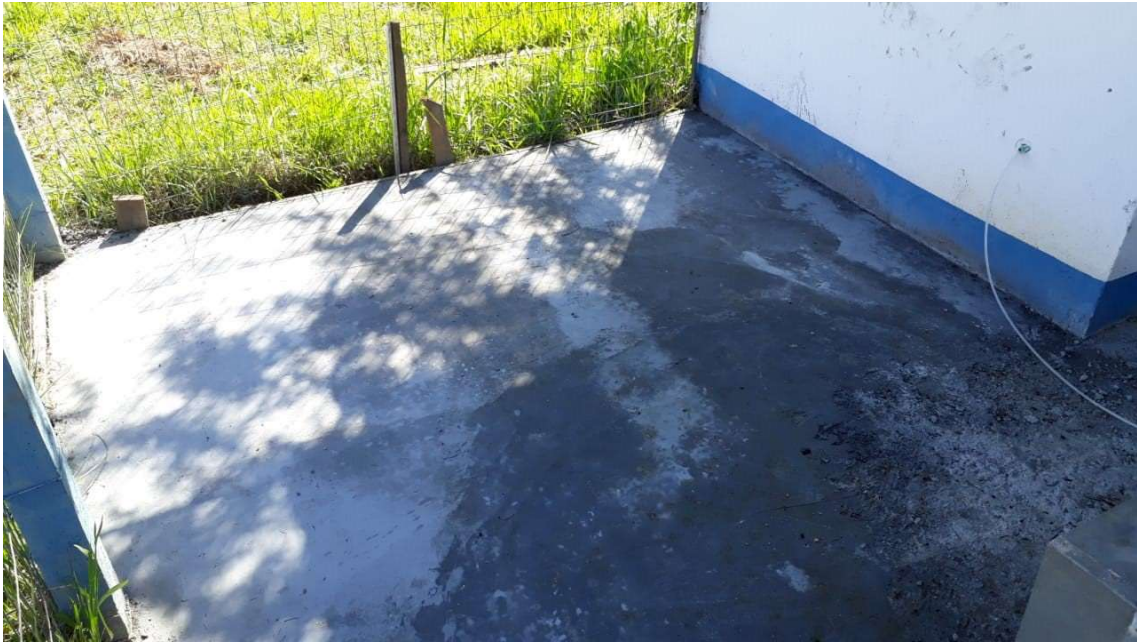
Figura 2. Laje sanitária reconstituída. Posição I.
