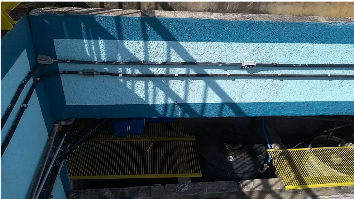
Figura 2. Instalação e ativação do sistema de ortopolifosfato em novo local contendo bacia de contenção e cobertura.
