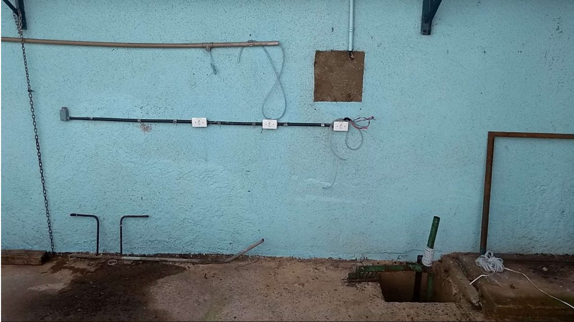
Figura 1. Desativação do sistema de ortopolifosfato no local anterior (remoção painel elétrico, bombas dosadoras, tanque e bombonas).
