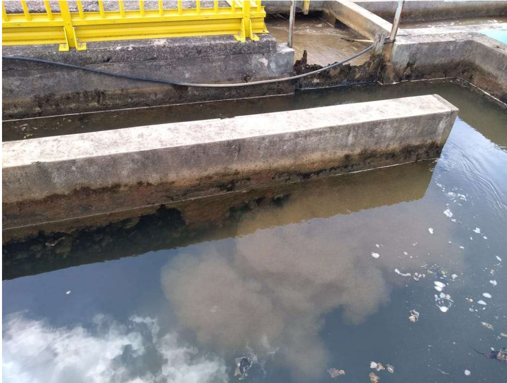
Figura 2. Unidades de tratamento de água do bloco hidráulico após procedimento de limpeza. Posição II.
