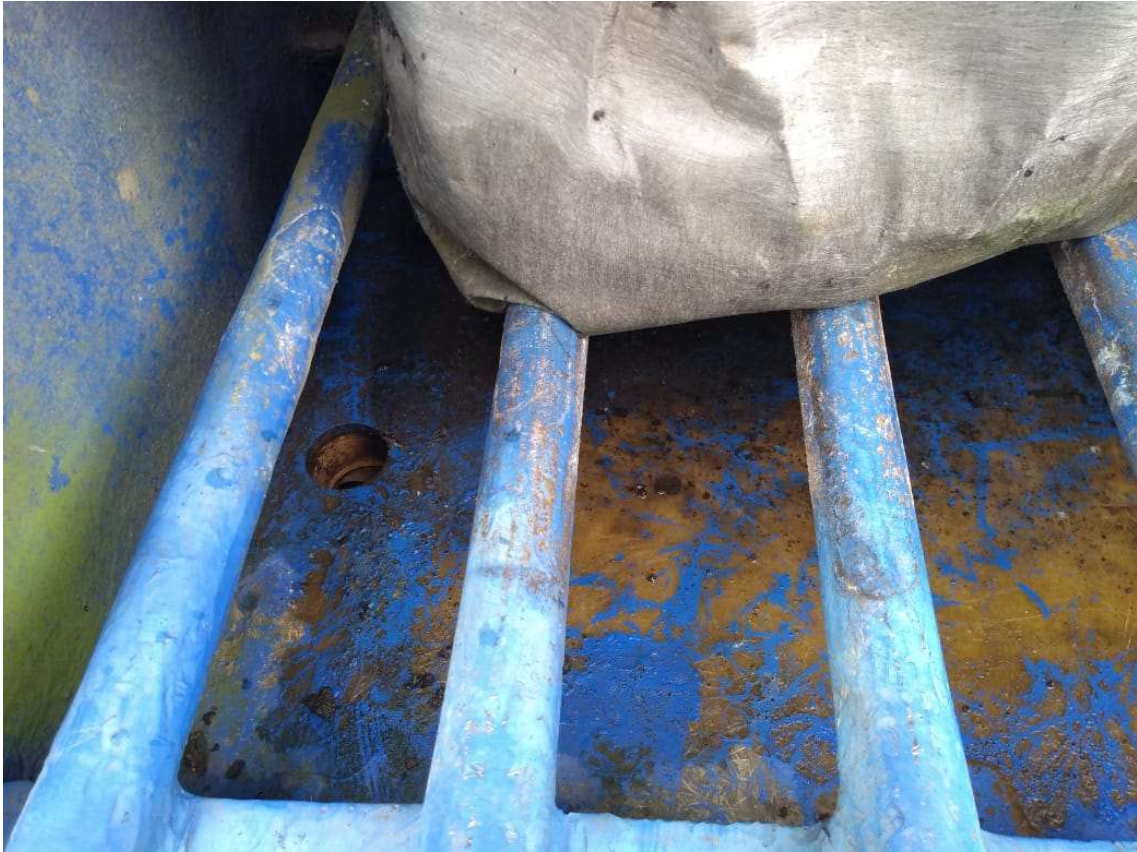
Figura 5. Sistema de drenagem do tipo bags para lodo desobstruído. Posição V.
