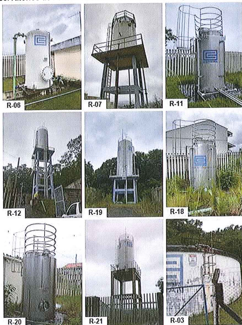
Figura 01: Reservatórios de Parobé visitados durante a fiscalização.
