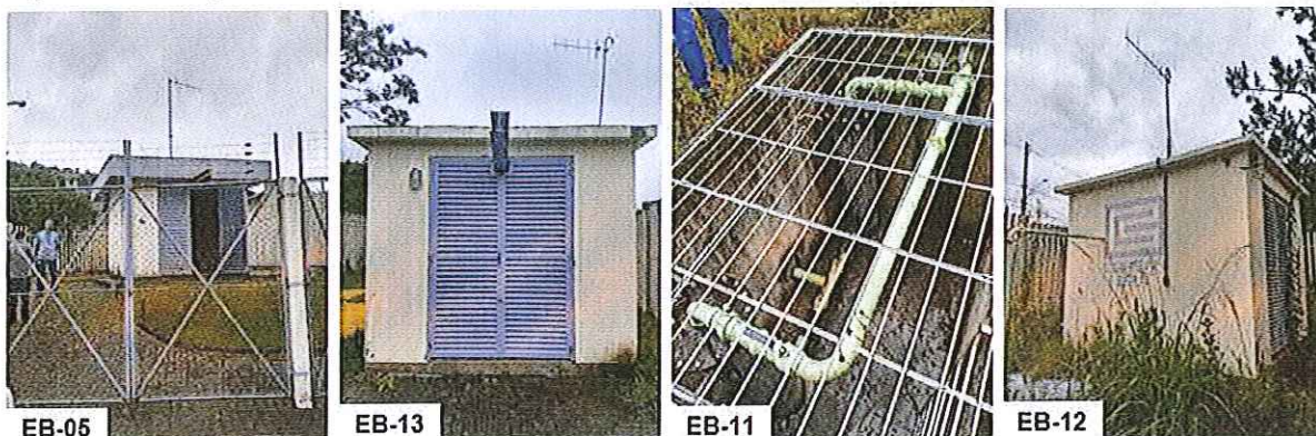
Figura 02: Estações de bombeamento de Parobé visitadas durante a fiscalização.
