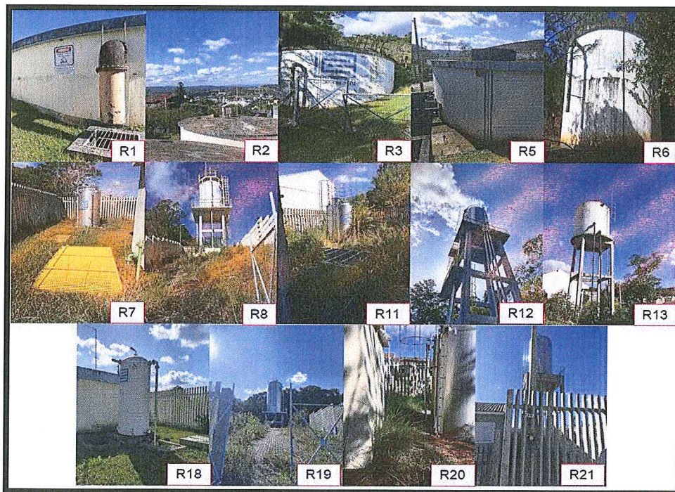
Figura 6: Vista dos Reservatórios Fiscalizados
